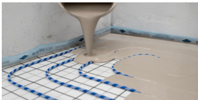
BLANKE FILLOCREED ist eine selbstverlaufende, pumpfähige und selbstnivellierende Energieverteilschicht für den Innenbereich, die durch ihren schnellen Festigkeitsaufbau, ihre sehr geringe Schichtdicke und ihre hohe mechanische Belastbarkeit überzeugt. Sie ist bereits nach 2-3 Stunden begehbar und nach 12 Stunden belegreif, wodurch sich besonders zügige Arbeitsabläufe realisieren lassen.
