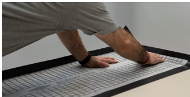
BLANKE DISK dient im System der BLANKE PERMATOP SF SPA nicht nur als normsichere Abdichtung, sondern auch als entkoppelnde Schicht.
